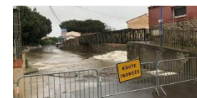
Sécurisation passage à gué
