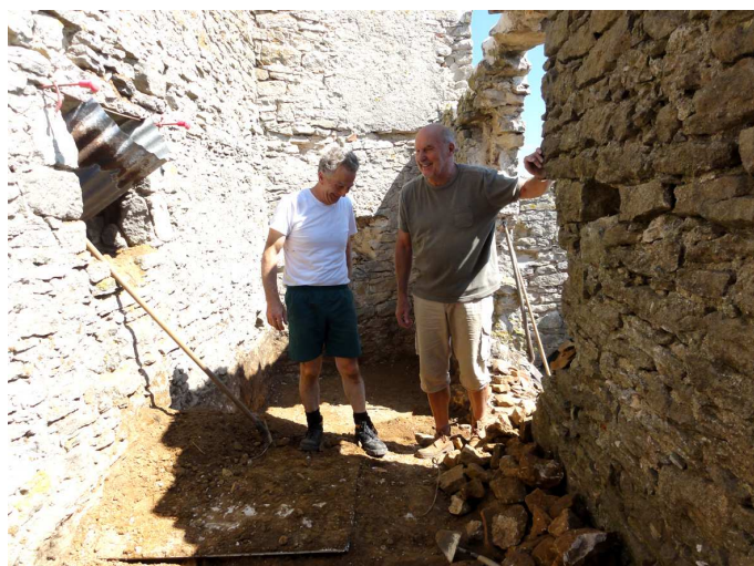
Nettoyage et étanchéité de la Tour
