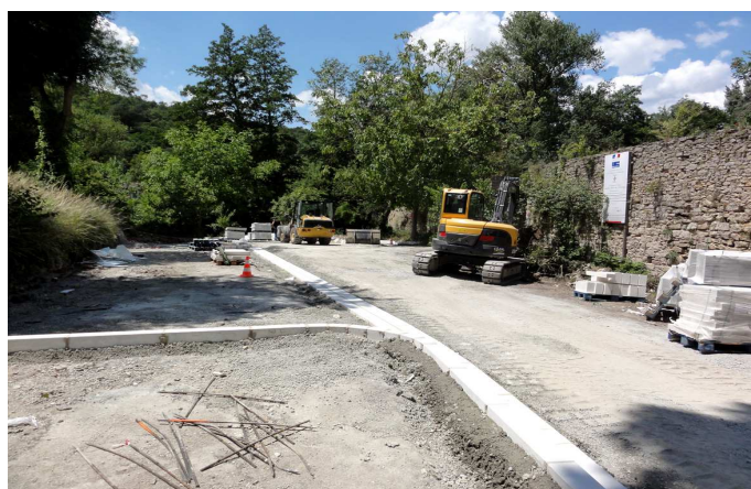
Travaux en cours à Villelongue.
